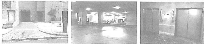
トラックヤードへの1階入口
