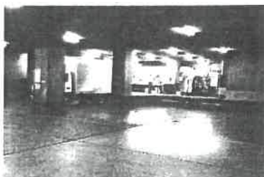
地下1階トラックヤード
